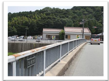
坂内川に架かる白猪橋
